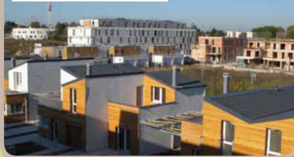
Les travaux des tranches 2 et 3
